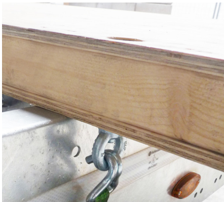
Zurröse in der Bodenplatte verankert
