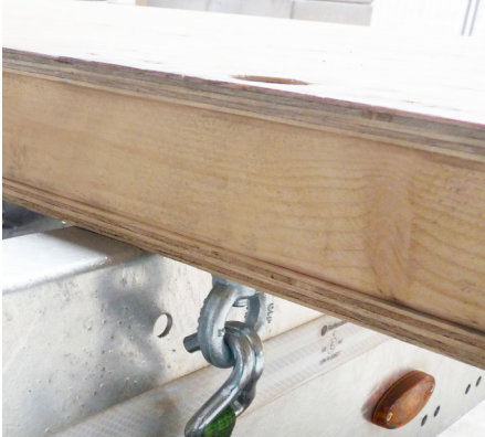
Zurröse in der Bodenplatte verankert
